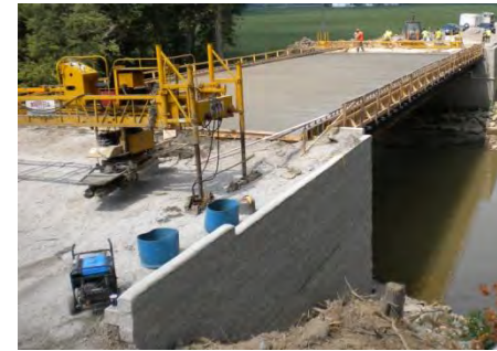
f) Concrete deck pour
