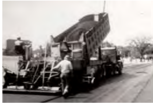
(d) Hot mix bituminous overlay being placed
