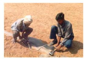
(d) Testing of seams with air pressure
