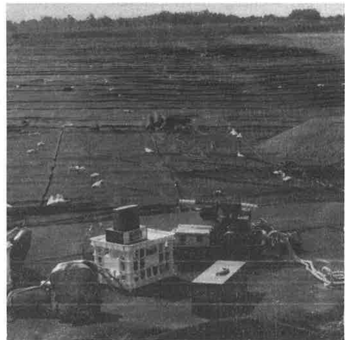
(d) Overview of Geotextile Covered Thermocouple Field
