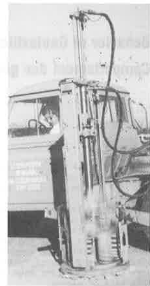
Fig. 5 - La compression dynamique est appliquée au moyen de la Dynaplaque
