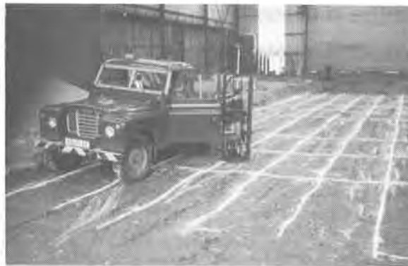
Figure 1 - Mesure de la déformabilité du sol-support avant mise en oeuvre de la couche granulaire et de l'enduit superficiel. Mesures à la Dynaplaque (chargement dynamique sur plaque 600 mm de diamètre).
