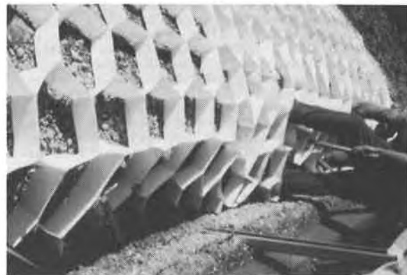
Fig. 3 - Dispositif d'ancrage en crête de talus
