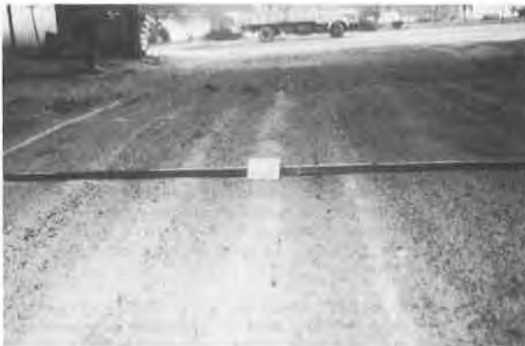
Figure 4 - Vue des déformations de surface correspondant au cas de la figure 3, à 52 passages de camion également.
