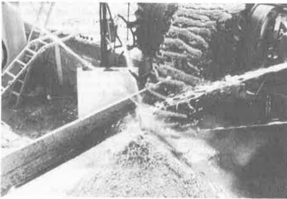
Figure 1 - Premiers essais en vraie grandeur en 1979. Les fils sont projetés par des jets d'eau.
