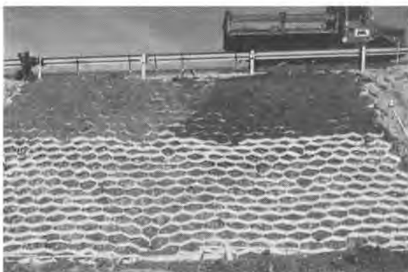
Fig.5 - Déformation de la nappe en cours de remplissage
